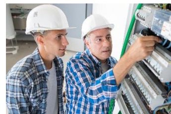
Arbejde med højspænding kræver oplæring og instruktion.
