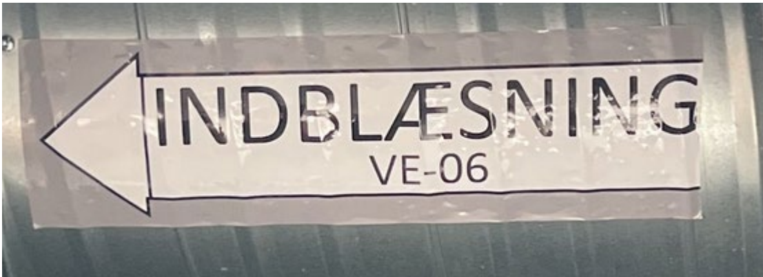
Figur 1 Eksempel på opmærkning af indblæsningskanal for VE06 med ekstra linje for luftmængde.
