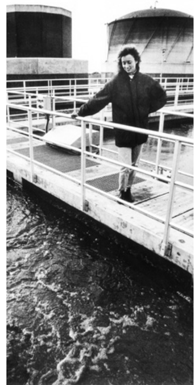
Foto ca. 1988 fra Renseanlæg Vest, Aalborg. Forskere fra Institut for Jord, Vand og Miljø med professor Jens Aage Hansen og lektorerne Kristian Keiding og Per Halkjær Nielsen i spidsen arbejdede sammen med Aalborg Kommune og firmaet Krüger om at udvikle metoder til slambehandling, herunder biologiske metoder til fosforfjernelse med henblik på at kunne udnytte slammet. Pigen på billedet er daværende civilingeniørstuderende i miljøteknik Elly Kjems Hove. Foto: Henning Bagger (AAU's billedsamling).
